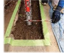
モルタル塗り作業
