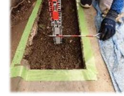
モルタル塗り作業
