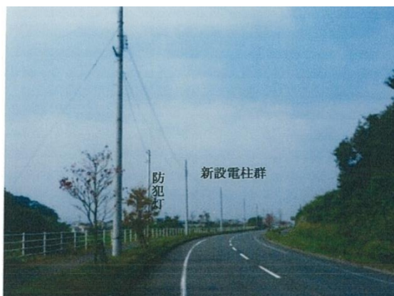
敷設した防犯灯
