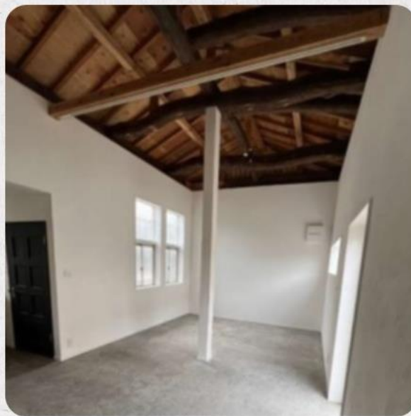
空き家リホームの様子
