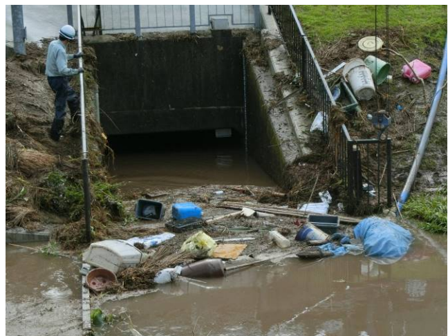
令和2年7月豪雨 左:排水機場の除塵機 右:水門に溜まった多量のゴミ
