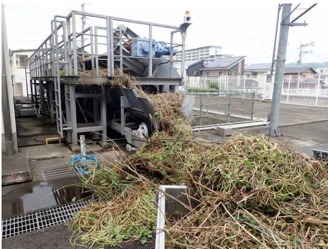
令和2年7月豪雨 左:排水機場の除塵機 右:水門に溜まった多量のゴミ
