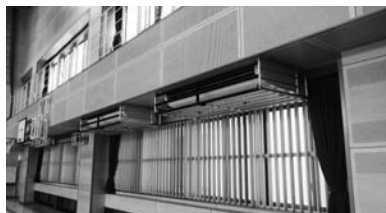
小中学校等屋内運動場空調設備整備事業
