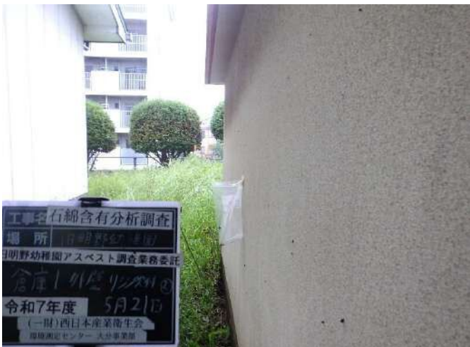
旧明野幼稚園 倉庫1 外壁 リン酸吹付②
