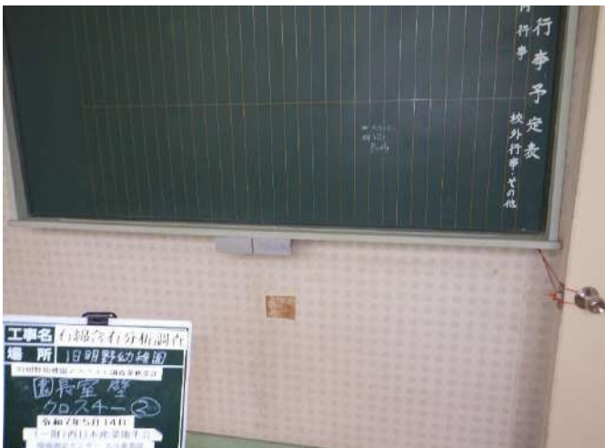
旧明野幼稚園 園長室 壁 クロス4②
