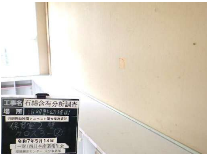
旧明野幼稚園 保育室2 壁 クロス3②
