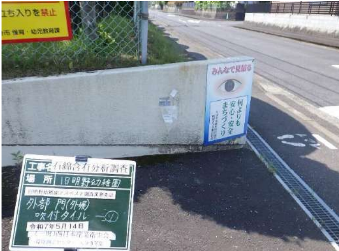
旧明野幼稚園 門(外塀) 吹付タイル①
