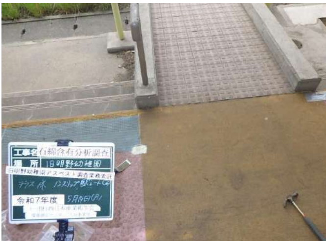
旧明野幼稚園 テラス 床 ノンスリップ長尺シート②
