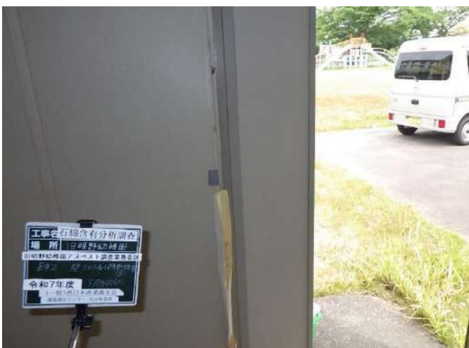
旧明野幼稚園 倉庫2 内部壁 クロス6+岩綿吸音板③
