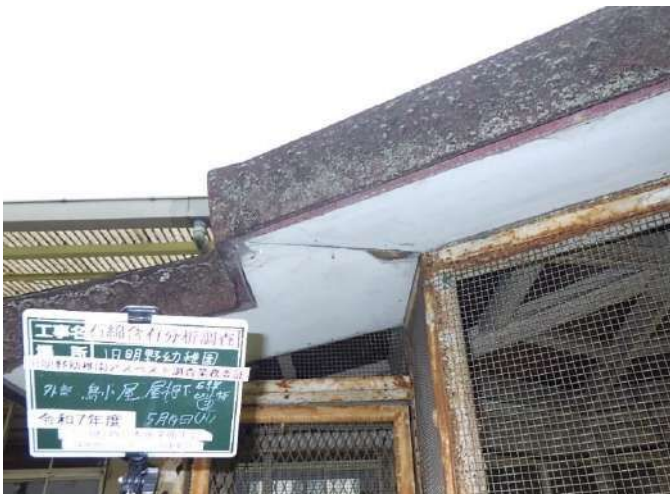
旧明野幼稚園 鳥小屋 屋根下 石綿セメント板③
