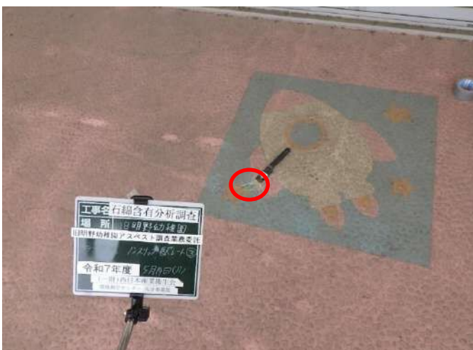
旧明野幼稚園 テラス 床 ノンスリップ長尺シート③
