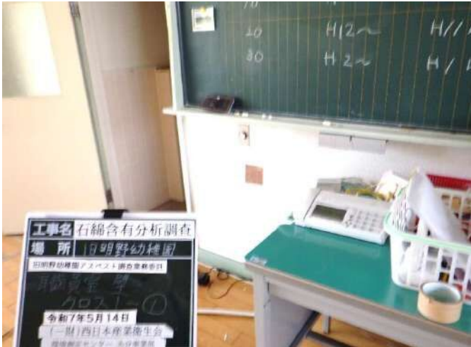
旧明野幼稚園 職員室 壁 クロス1①
