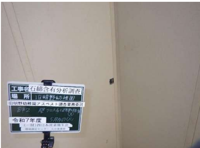
旧明野幼稚園 倉庫2 内部壁 クロス6+岩綿吸音板②
