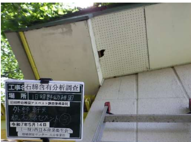
旧明野幼稚園 軒天 有孔石綿セメント板③
