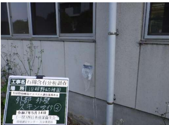
旧明野幼稚園 外壁 スキン吹付③
