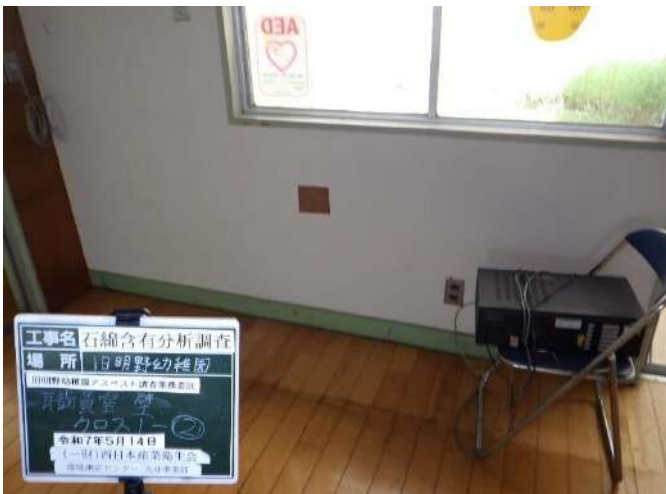
旧明野幼稚園 職員室 壁 クロス1②
