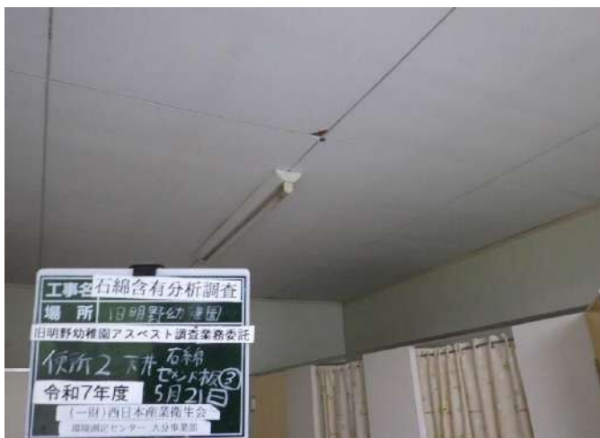
旧明野幼稚園 便所2 天井 石綿セメント板VP塗り③
