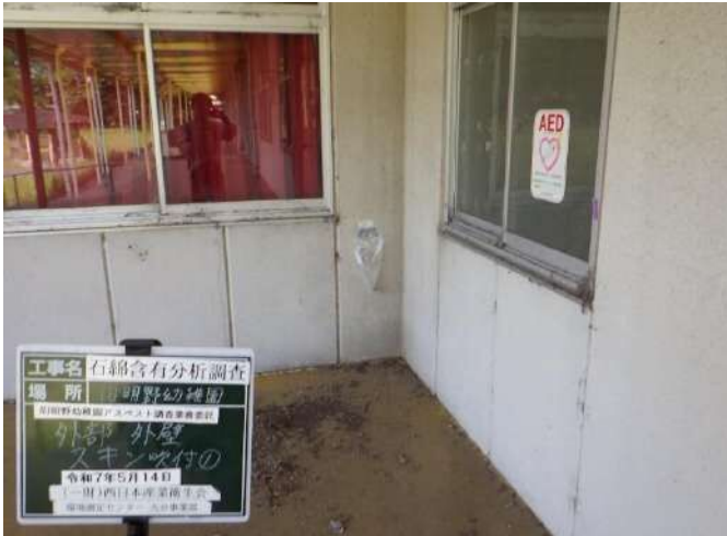
旧明野幼稚園 外壁 スキン吹付①
