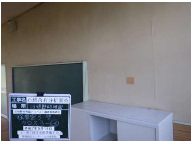
旧明野幼稚園 保育室3 壁 クロス3③
