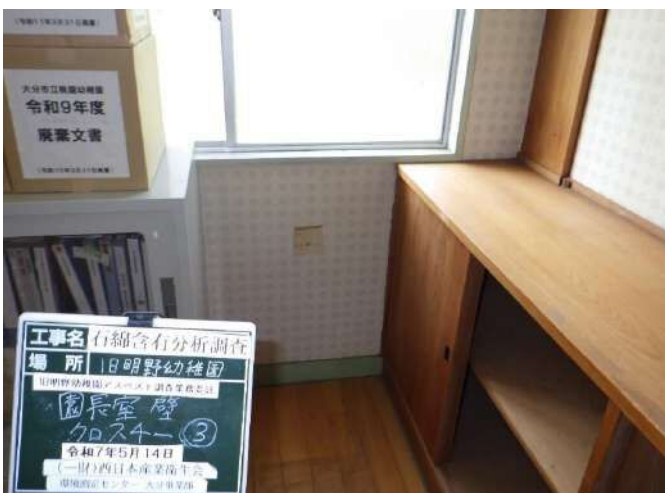
旧明野幼稚園 園長室 壁 クロス4③
