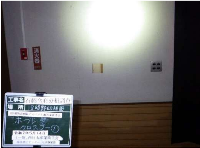
旧明野幼稚園 ホール 壁 クロス2①
