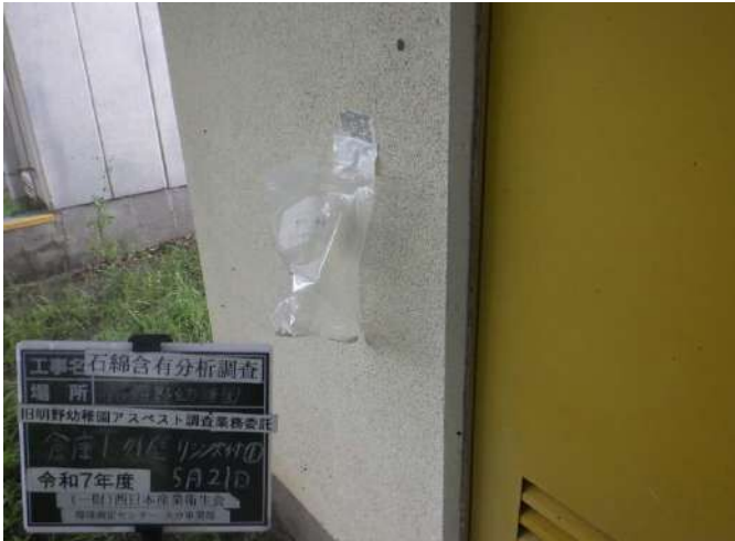
旧明野幼稚園 倉庫1 外壁 リン酸吹付①
