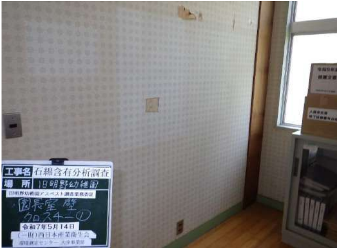
旧明野幼稚園 園長室 壁 クロス4①
