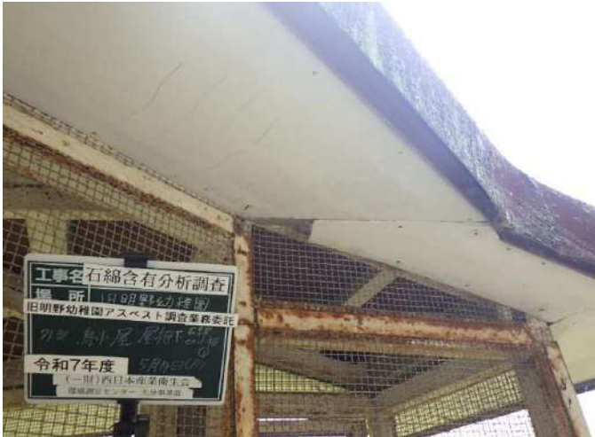
旧明野幼稚園 鳥小屋 屋根下 石綿セメント板①
