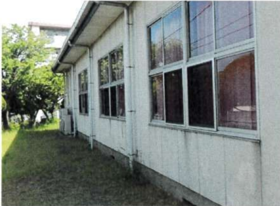
立上り、外壁、外壁目地
