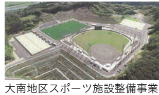
大南地区スポーツ施設整備事業
