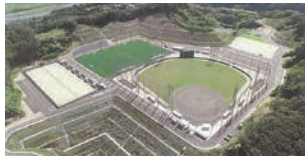
大南地区スポーツ施設整備事業
