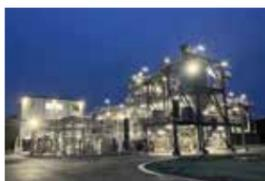
大分市および県内8自治体から排出される下水汚泥を集約し、石炭等の代替燃料として固形燃料を製造・利用する施設を稼働しています。
