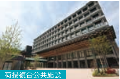
荷揚複合公共施設
