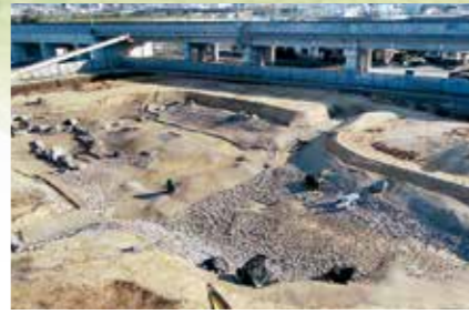
整備工事状況全景
