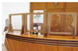
窓口に飛沫感染防止ガードを設置
