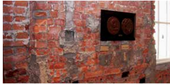
建設当時のれんが壁。 れんがはイギリスから直輸入された。
