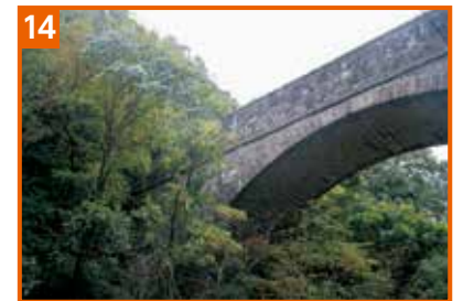
14 昭和井路水路橋群 1940～50年代に建てられた4つの水路橋(写真は太谷川水路橋)
