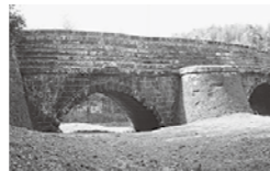
明治大分水路橋
