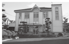
フジボウテキスタイル株式会社 大分工場 事務棟
