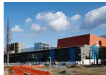
3 ホルトホール大分(建設中) (7月20日オープン予定)
