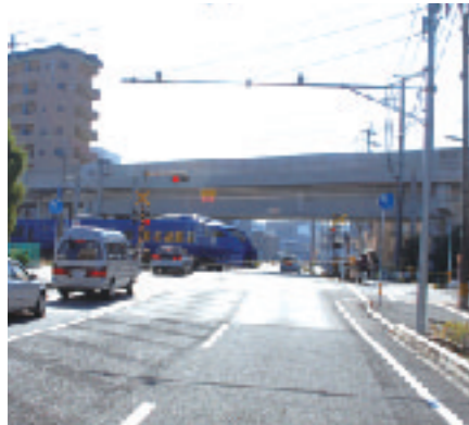
高架工事が進む春日通り踏切
