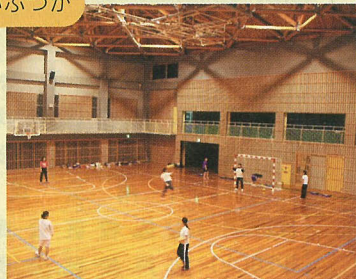
市立王子中学校体育館
