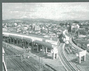
高架が進む六坊北町付近
