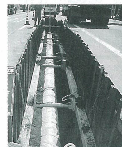
配水管布設工事
