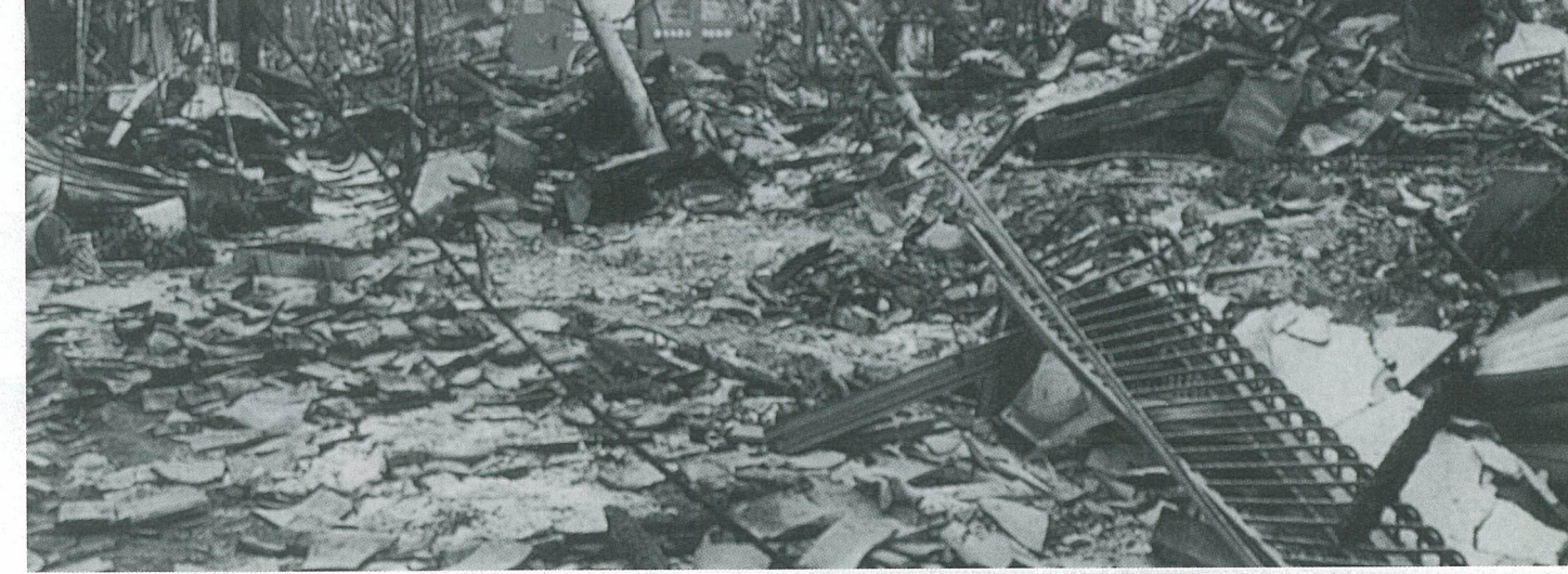
阪神・淡路大震災で焼失した神戸市長田区菅原市場
