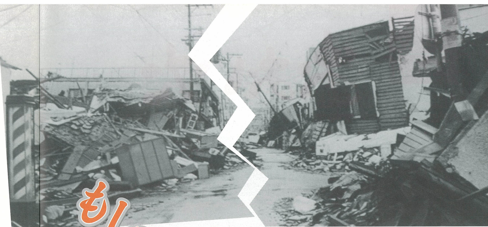
▲7年1月17日に発生した阪神・淡路大震災で倒壊した家屋
