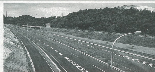
E 国道197号大分南バイパス
