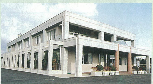
省エネ対策を採用しています ～西部清掃事業所移転改築～ 2月29日 横瀬
