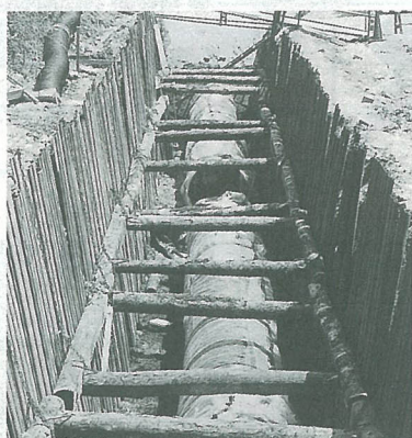
配水管布設工事
