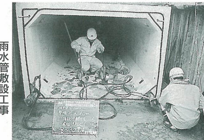
雨水管敷設工事
