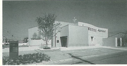
▲松本内科循環器科クリニック [下郡] 美術館のような外観をもつこの病院。内部にもこだわった造りに、施主の思い入れを感じます。特徴的な造りながら、付近の住宅にも違和感なく溶け込んでいます。
