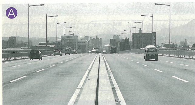
臨海工業地帯を東西に結ぶ県道大在大分港線の中島十条交差点から大野川右岸までの全区間(9.2km)が6車線となりました。
