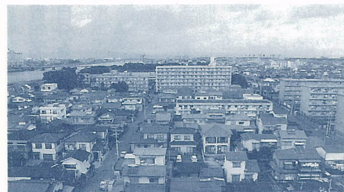
きれいに整備され、住宅が立ち並ぶ岩田町
