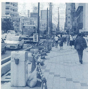
▲電線類の地下埋設が進む中 央通り
