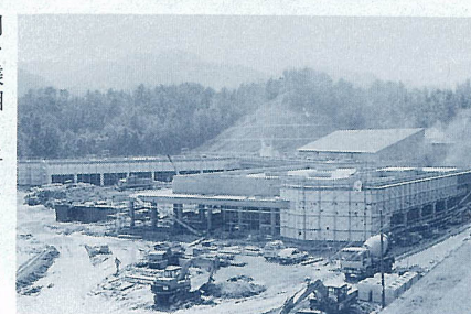
10月の開場に向けて工事が進められている葬斎場
