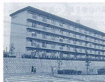
市営明治北住宅
