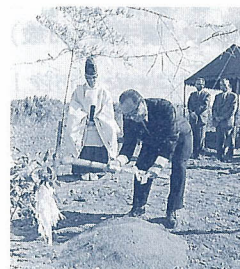
原川下水処理場着工 (昭和43年)
