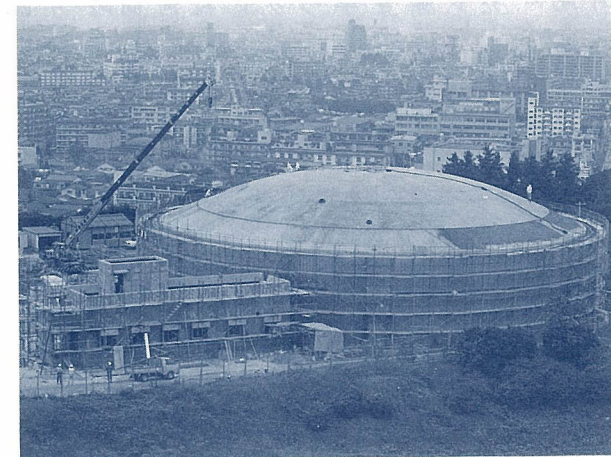
増設が進む三芳配水池
