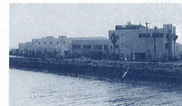
最新鋭の設備を導入した原川終末処理場
