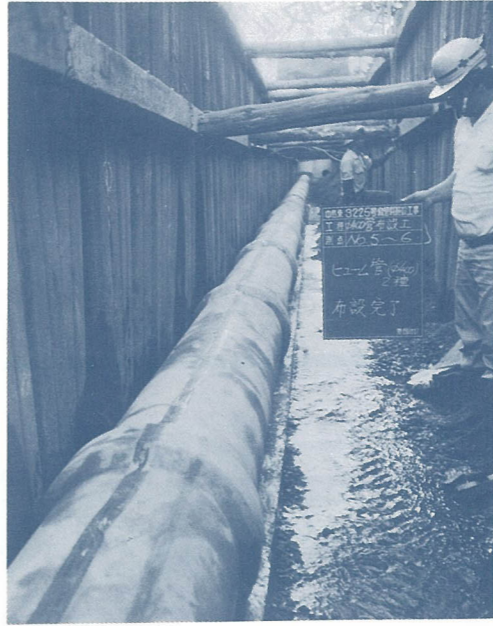
下水管の布設工事(中島東)
