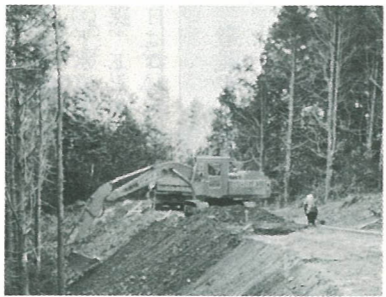
開設が進む白山若山林道
