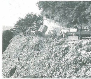
急傾斜での作業
