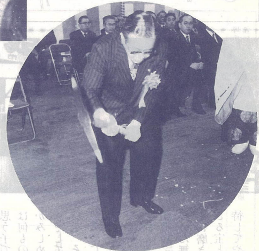
▲(仮称)東部清掃工場 62年3月完成めざして着工 1月14日、坂ノ市佐野理立場の隣接地で(仮称)東部清掃工場の安全祈願祭、起工式が行われました。 新清掃工場は1日の処理能力150トンの焼却炉を2基設置し、総事業費は約71億円。62年3月末の完成へむけて、着工しました。
