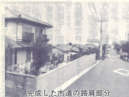
完成した市道の路肩部分
