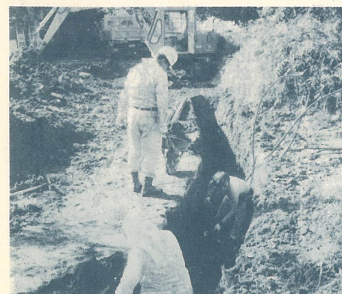
配水管工事 (白木地区)
