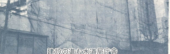
建設の進む水道局庁舎
