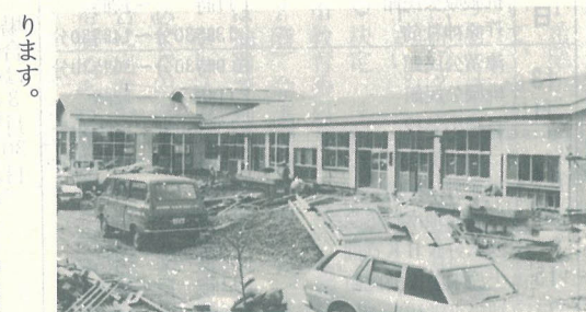
急ピッチで工事が進む舞鶴幼稚園
