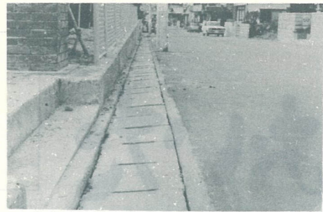
道路と側溝が出来ました(西大分)
