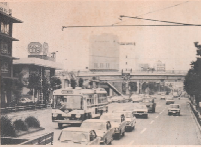
車の流れをコンピューターで管理(昭和通りで)
