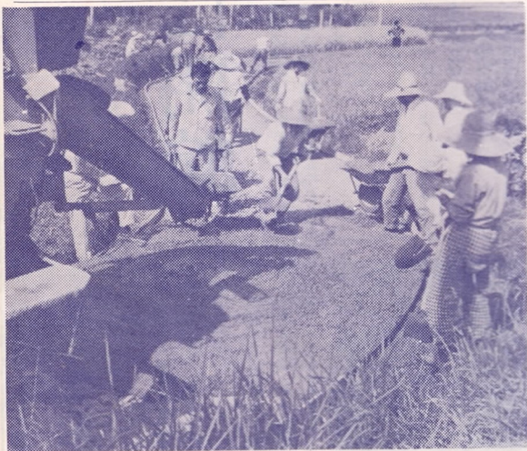
原材料支給の農道舗装（横瀬で）
