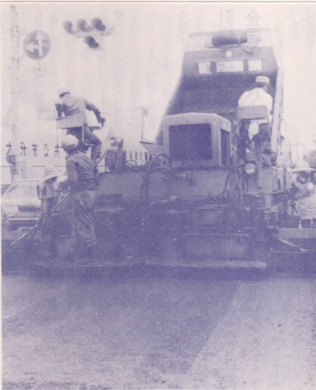
進む道路舗装
