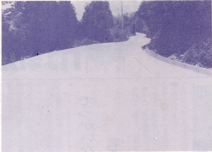
完全舗装された田の浦農道
