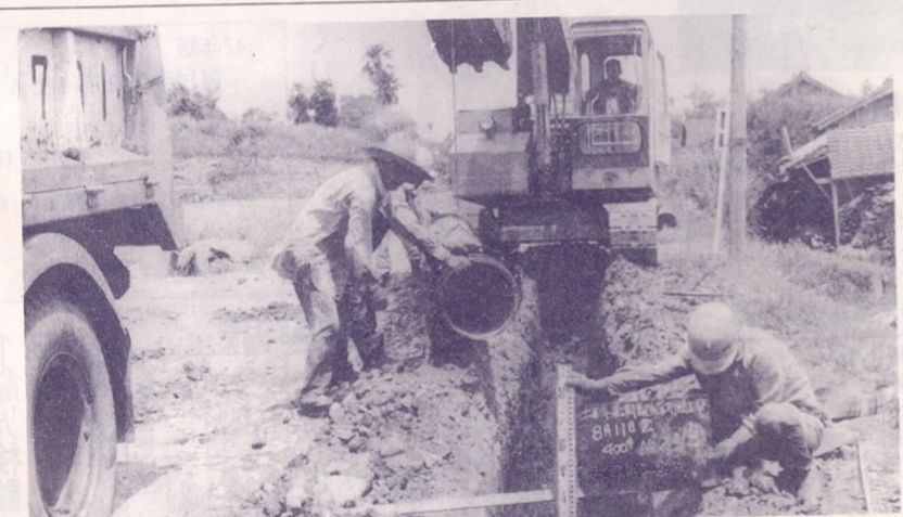
配水管整備工事もすすむ
